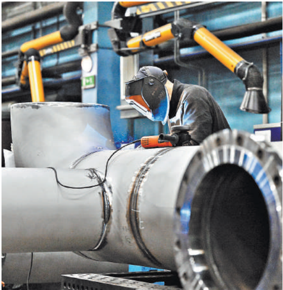
Строительство нового газопровода в Китае — дело не одного года, требующее больших финансовых вложений.
