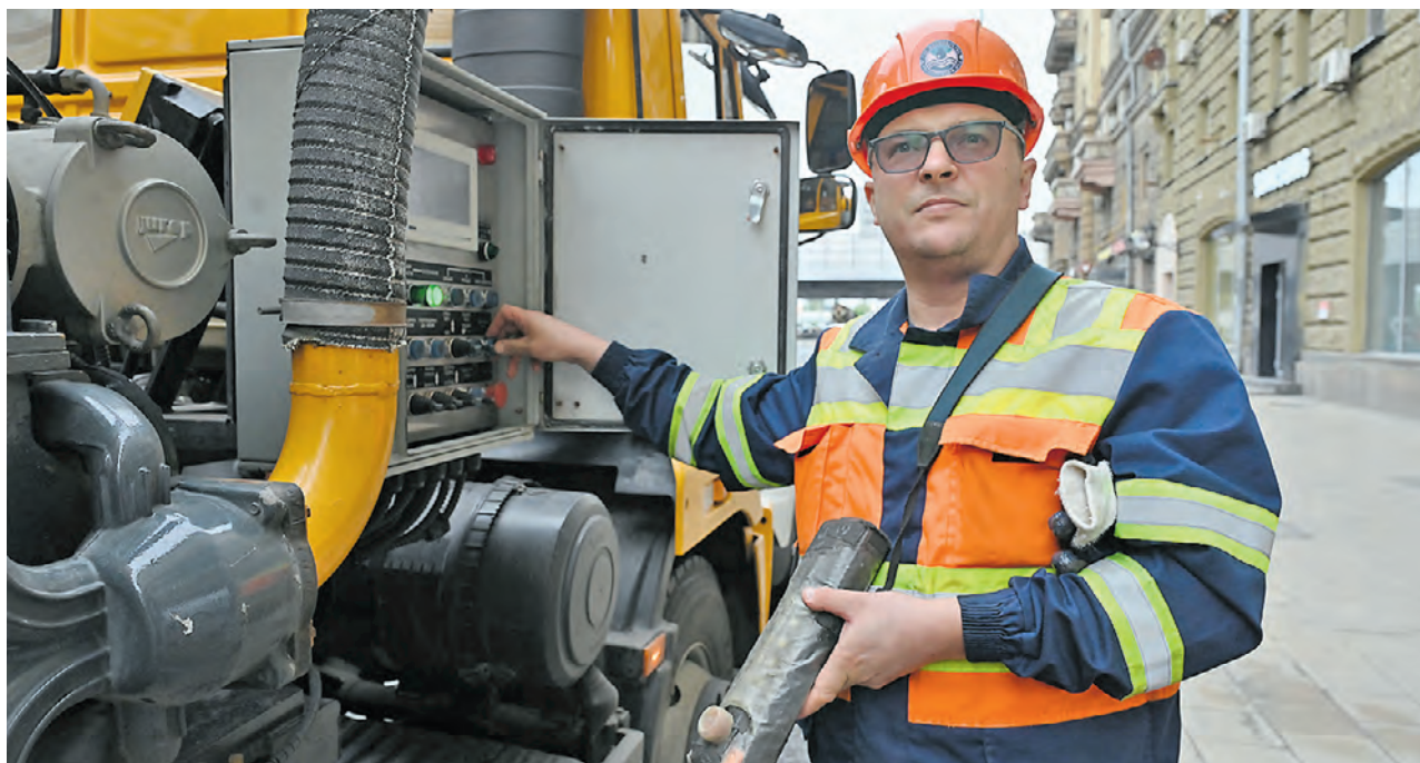
14 июня. Участник бригады «Мосводосток» Сергей Стенин работает на проспекте Мира. фото: АЛЕКСАНДР КОЧУБЕЙ
