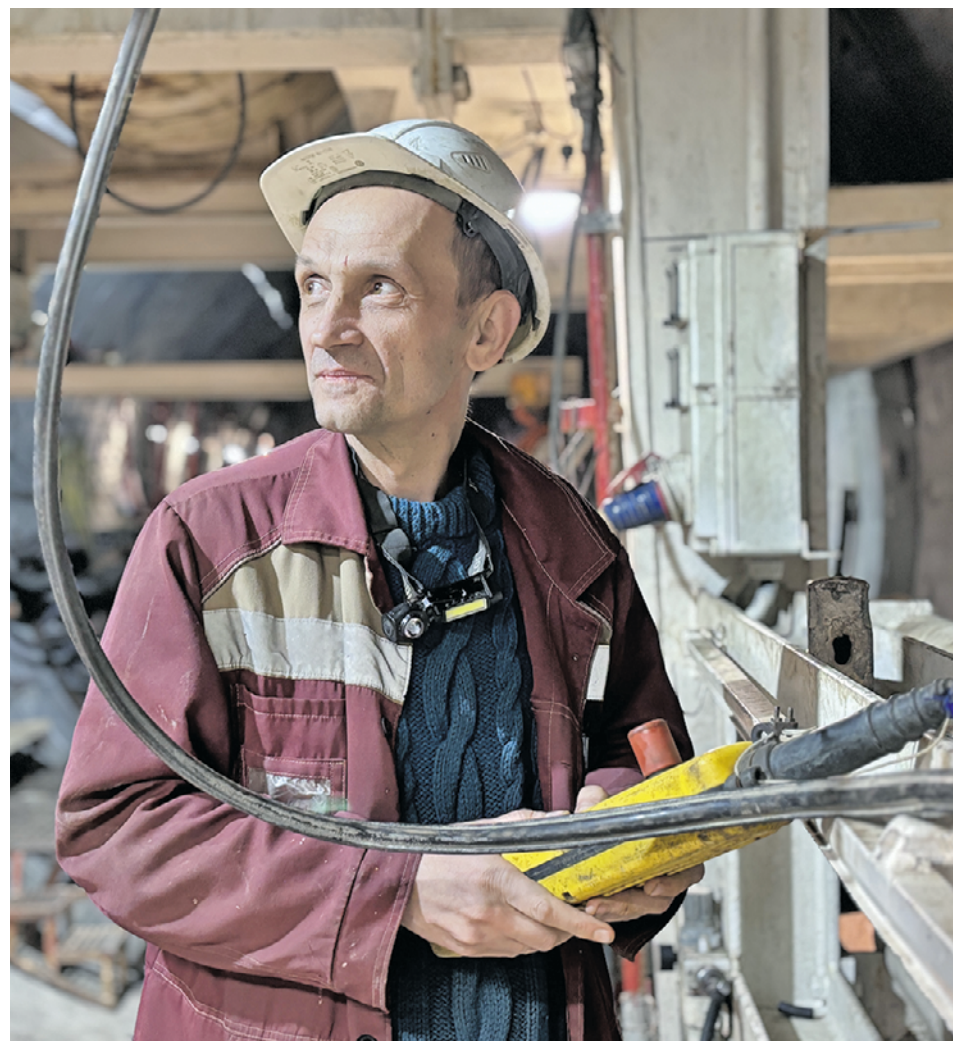
1 июня. Электромеханик проходческого щита Виталий Большаков осматривает «Ольгу». ТПМК прокладывает тоннель на Бирюлевской линии метро. ФОТО: ВАСИЛИСА ЧЕРНЯВСКАЯ
