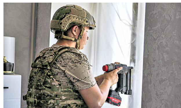
22 мая. Участник группы быстрого реагирования заделывает оконные проемы, чтобы сохранить тепло
