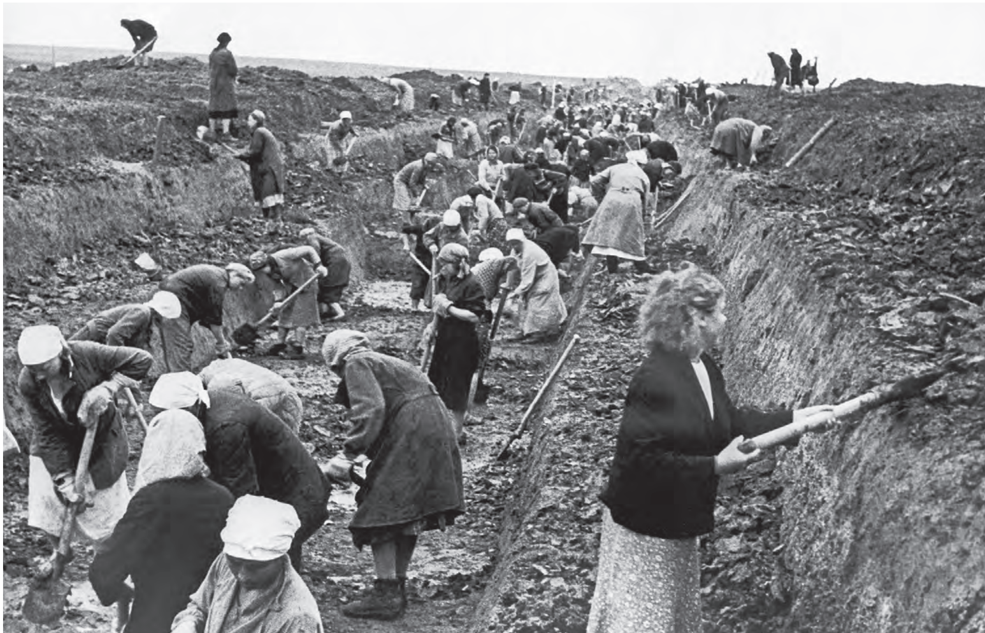
8 июля 1941 года. Комсомольцы на строительстве оборонительных сооружений под Москвой. Так и выглядел этот бесконечный противотанковый ров...
