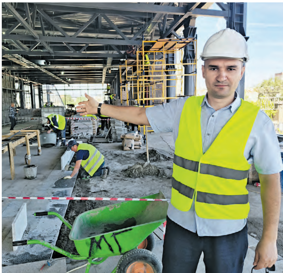
23 июня. Представитель ОАО «РЖД» Андрей Ковешников показывает, как идет ремонт на станции «Серп и Молот». ФОТО: АНДРЕЙ ОБЪЕДКОВ
