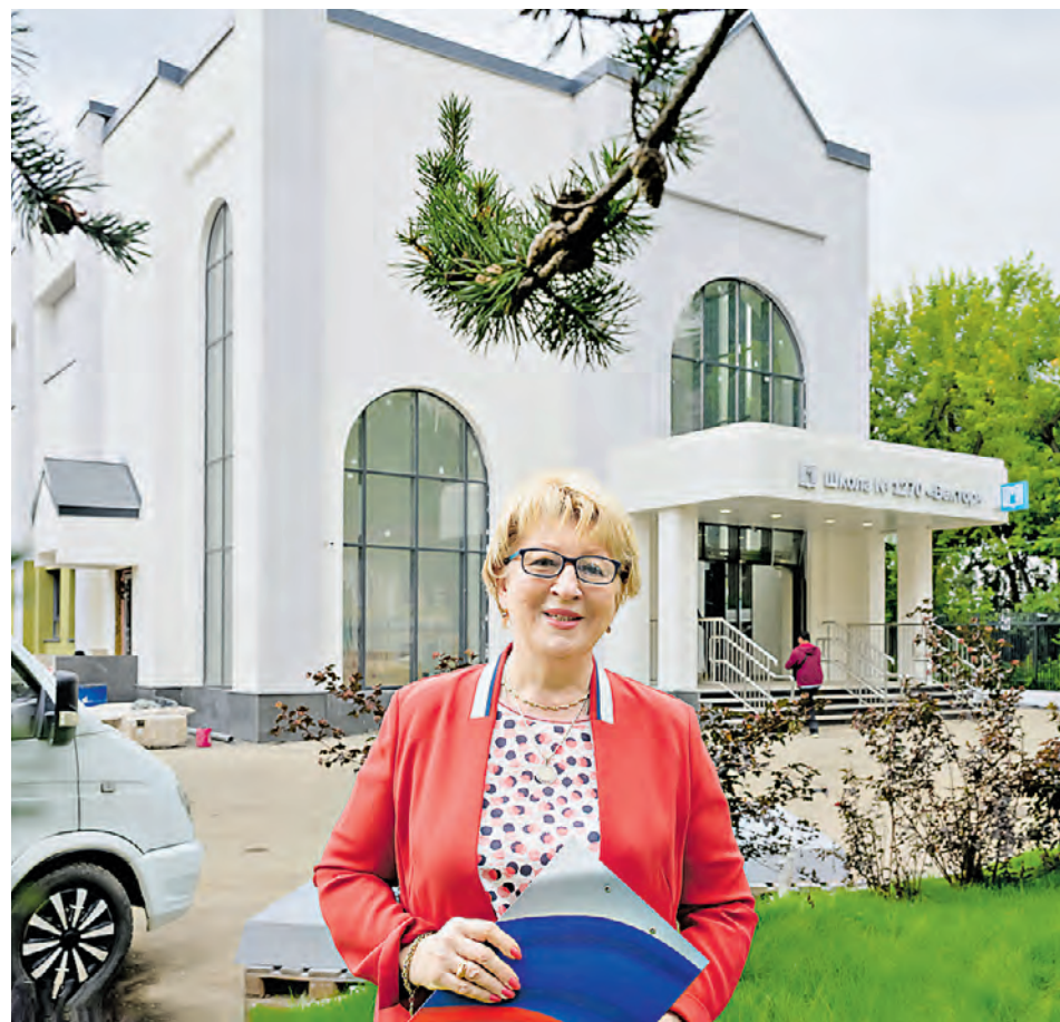
25 июня. Директор школы № 1270 «Вектор» Вера Кинешова на фоне здания в Товарищеском переулке, где завершаются работы по реконструкции. ФОТО: ДМИТРИЙ ДУБИНСКИЙ
