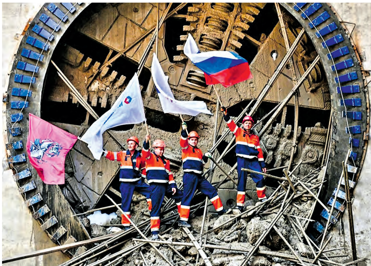
16 июля. Завершению проходки тоннеля рады арматурщики Роман Саверов и Сергей Пчельников, монтажник стальных и железобетонных конструкций Николай Ярцев и бетонщик Денис Литовченко (слева направо)
