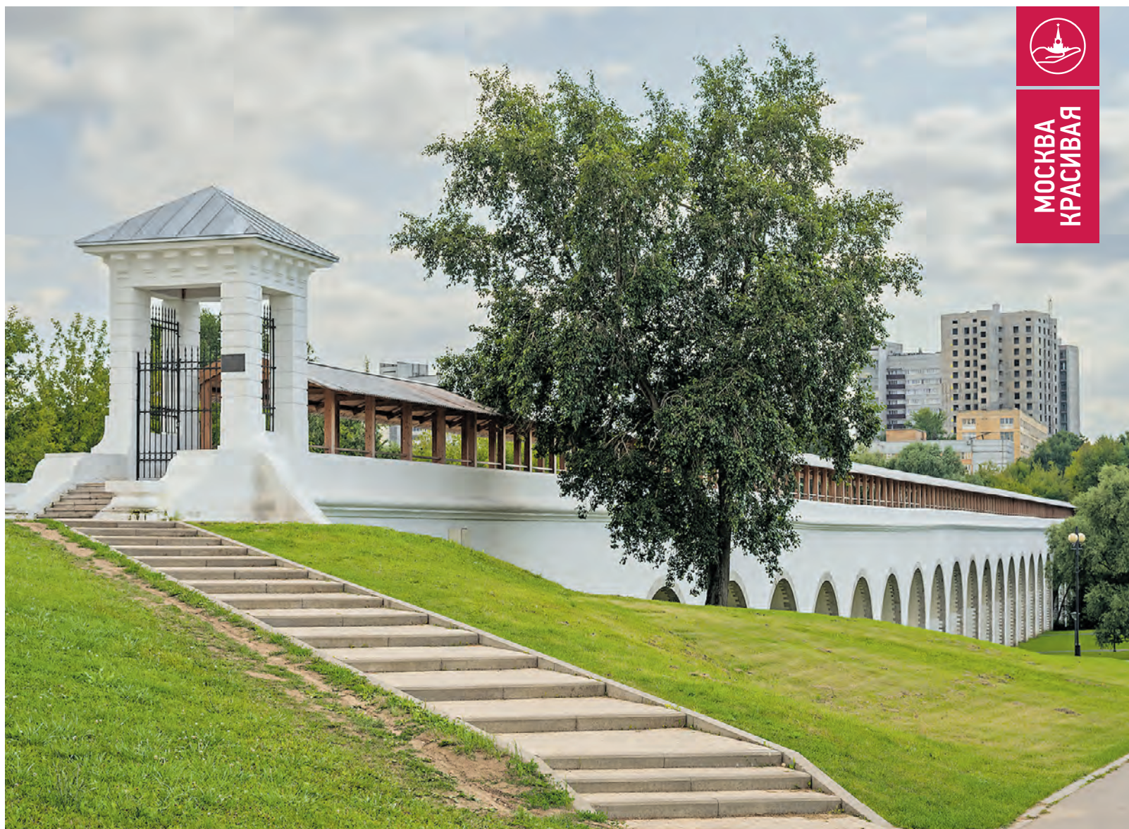
Ростокинский акведук — единственное в России сохранившееся сооружение такого рода, часть первого Мытищинского самотечного водопровода, созданного по указу Екатерины II. Одна из достопримечательностей не только столичного северо-востока, но и города в целом. Сегодня акведук — часть прогулочного познавательного маршрута нового парка «Яуза». ФОТО: ДМИТРИЙ ДУБИНСКИЙ
