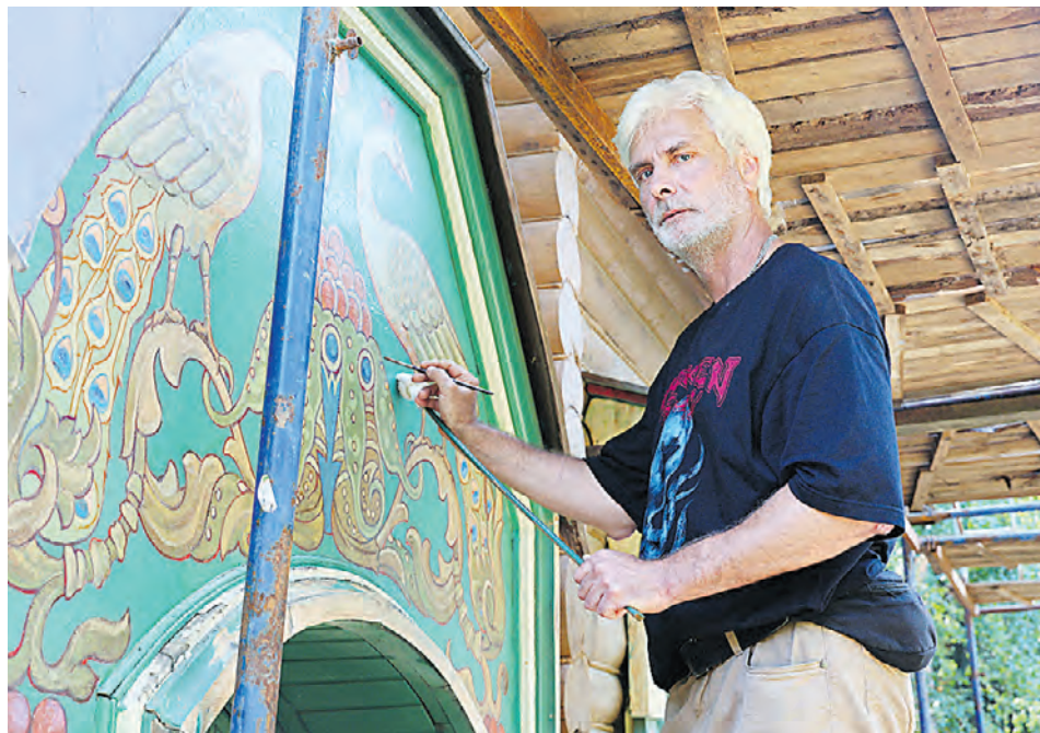
6 августа. Художник-реставратор Константин Васин работает над восстановлением орнамента на фасаде дачи Александра Левенсона. ФОТО: илья прошин
