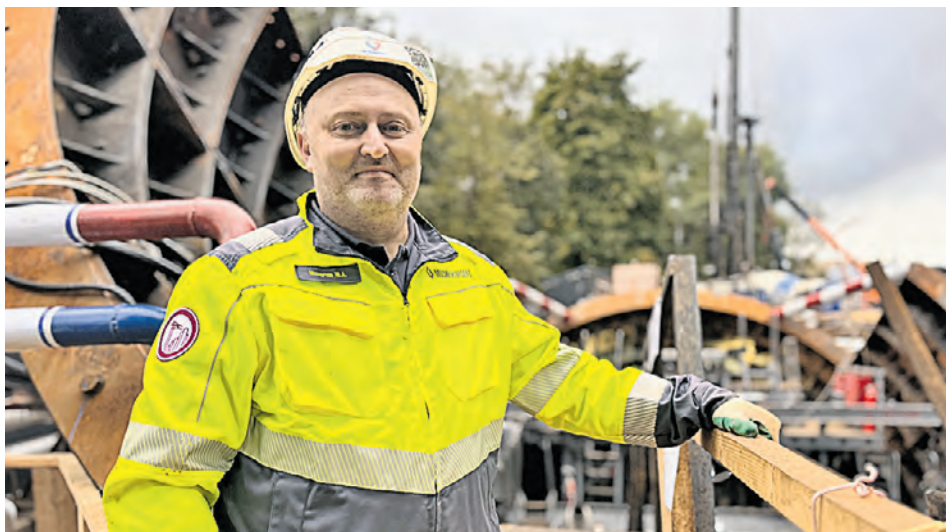
18 сентября. Замдиректора по строительству генподрядчика Юрий Мамычев проверяет ход работ наклонного хода станции метро «Достоевская». ФОТО: ВАСИЛИСА ЧЕРНЯВСКАЯ
