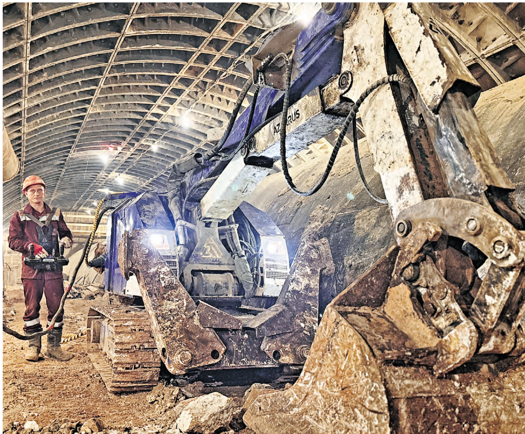
18 сентября. Оператор механизированного комбайна Игорь Родин управляет роботом, разрушающим породу. ФОТО: ВАСИЛИСА ЧЕРНЯВСКАЯ
