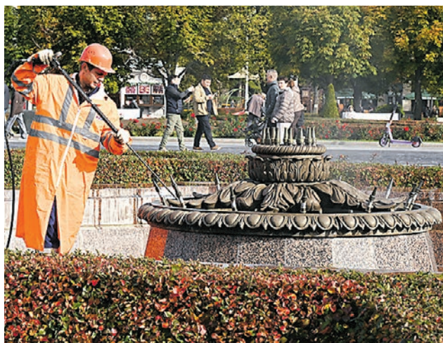
8 октября. Рабочий Вадим Вершинин промывает фонтан под высоким давлением. ФОТО: АНАТОЛИЙ ЦЫМБАЛЮК
