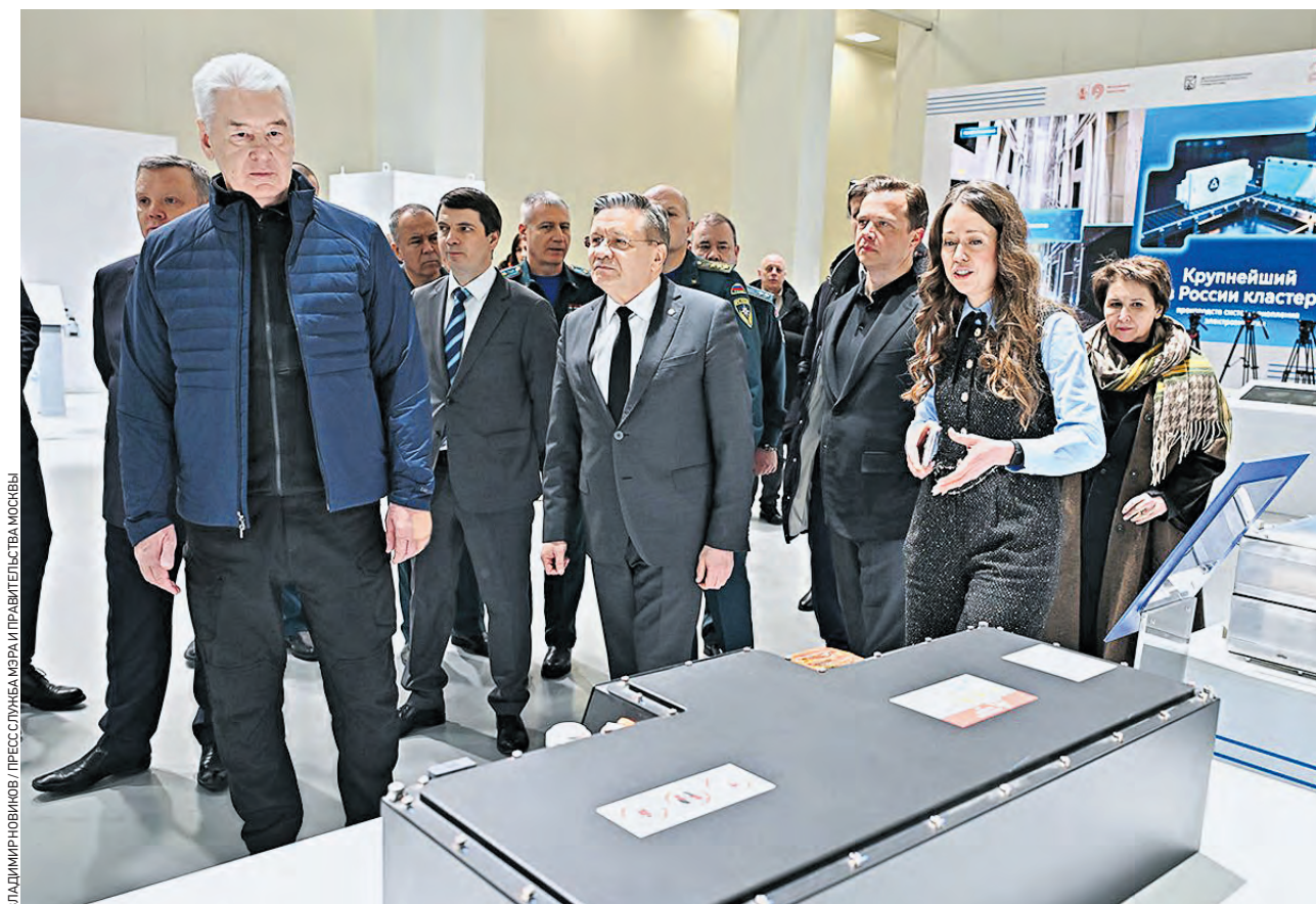
16 февраля. Мэр Москвы Сергей Собянин (слева) проинспектировал ход строительства двух заводов по производству аккумуляторных батарей на территории особой экономической зоны «Технополис Москва» в Краснопахорском районе ТиНАО
