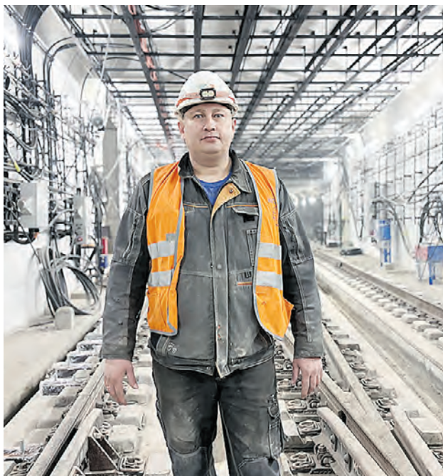
14 мая. Сварщик Сергей Иванов обходит тоннель на станции. ФОТО: ВАСИЛИСА ЧЕРНЯВСКАЯ
