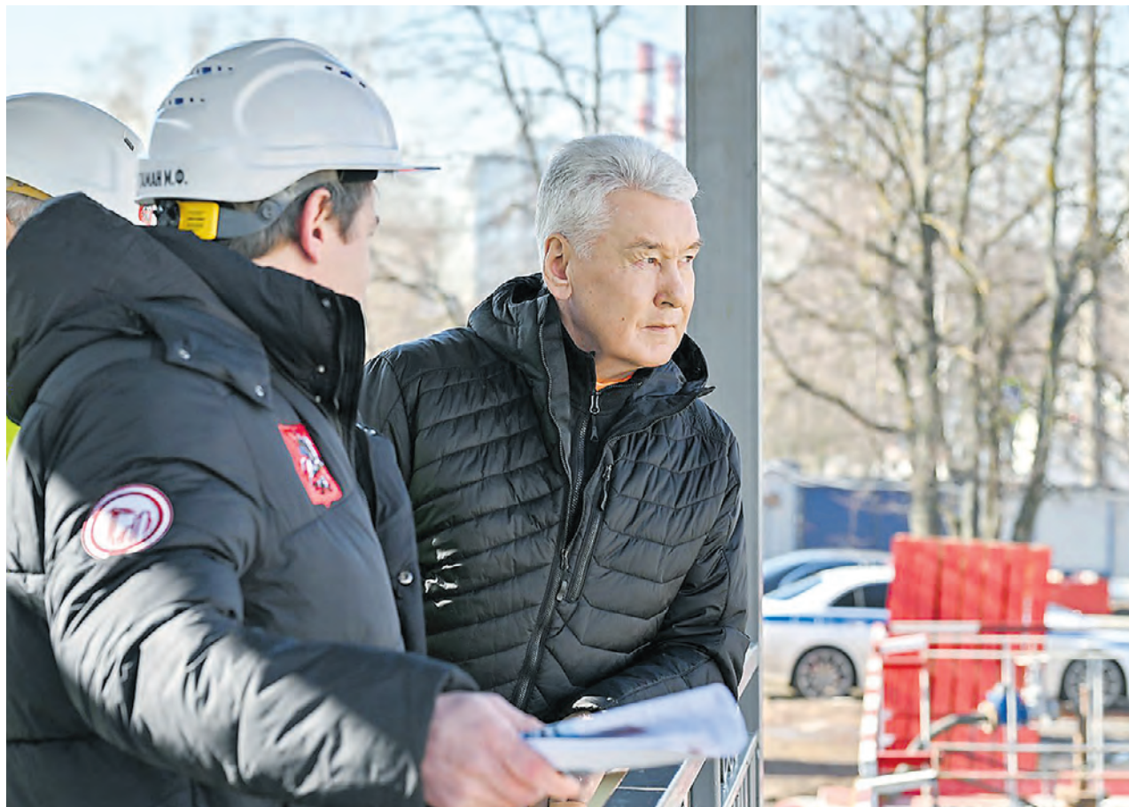
11 марта. Мэр Москвы Сергей Собянин осматривает строящуюся станцию «Гольяново» Арбатско-Покровской линии метрополитена. Она расположится вдоль Уссурийской улицы на пересечении с улицами Сахалинская и Хабаровская
