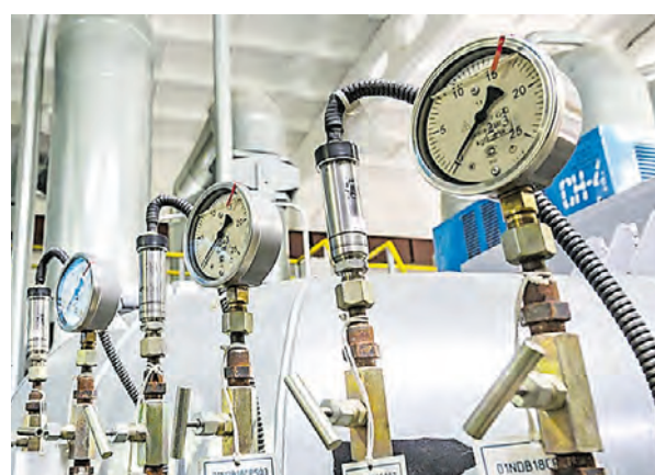
Горячую воду отключают в домах на 10 дней. В этот период проводят гидравлические испытания тепловых сетей
