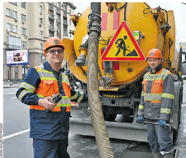
Участники бригады «Мосводостока» Виталий Брагин и Сергей Сенин (слева) работают на проспекте Мира
