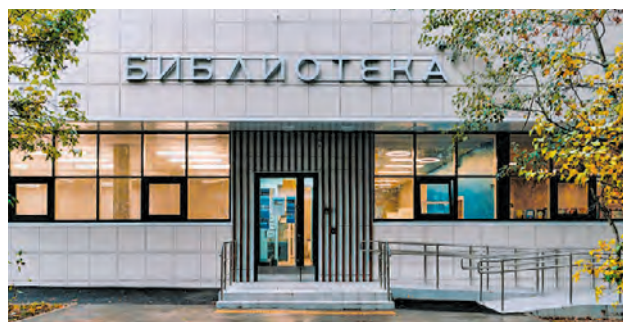
Детская библиотека № 137 в Бирюлеве Восточном после капитального ремонта
