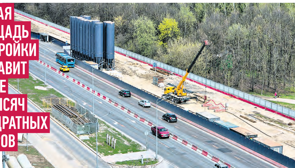
Строительство Бирюлевской линии метро в районе Бирюлево Восточное
