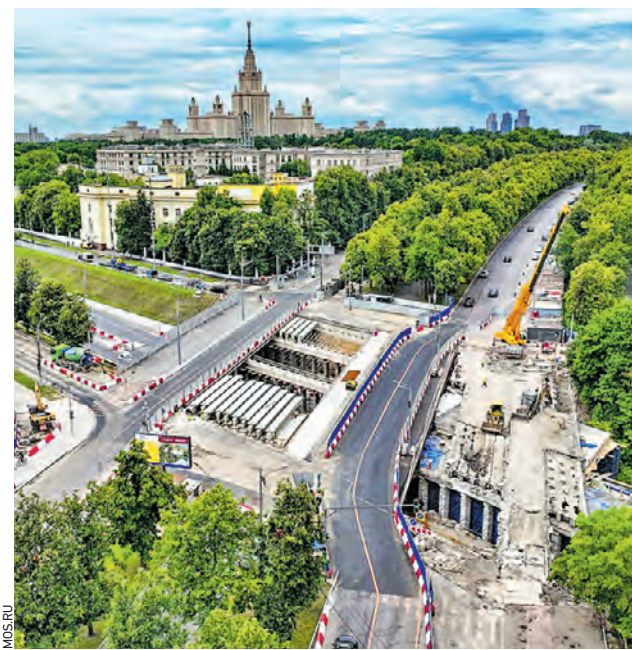
Во время проведения работ Воробьевский путепровод продолжает выполнять свою основную функцию
