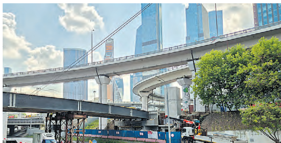
Строительство путепровода над Шмитовским проездом в рамках реконструкции улично-дорожной сети у транспортного узла «Москва-Сити»
