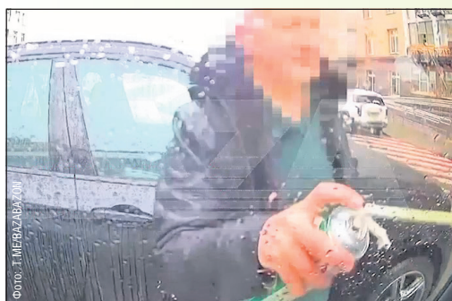
Дмитрий взял баллон с монтажной пеной...
